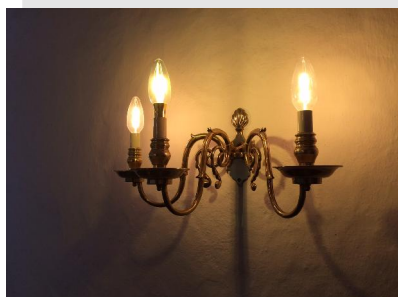
Lampet med 2 x 40W kirkekerte — og 4 W LED-kerte i midten
